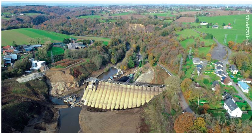
Septembre 2020. La suppression du barrage de La-Roche-qui-Boit sur la Sélune, à Ducey (Manche), commence avec le retrait des sédiments accumulés au fond du lac et comblant le lit mineur de la rivière depuis la dernière vidange, il y a trente ans. Suivra la vidange à proprement parler, courant 2021. Le calendrier est arrêté, la Sélune va retrouver son cours après un siècle d'immersion.
