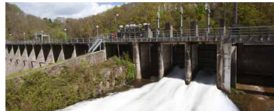
L'ouvrage de la Roche-qui-Boit a été construit en 1919.
