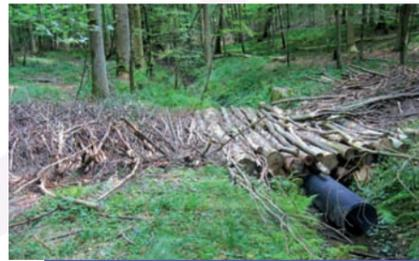
Restauration des écoulements par la pose d'ouvrages adaptés au niveau des zones de franchissement des engins forestiers.
