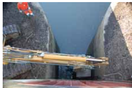
L'intervention d'un tracto-pelle a été nécessaire pour libérer la fosse d'anticipation.
