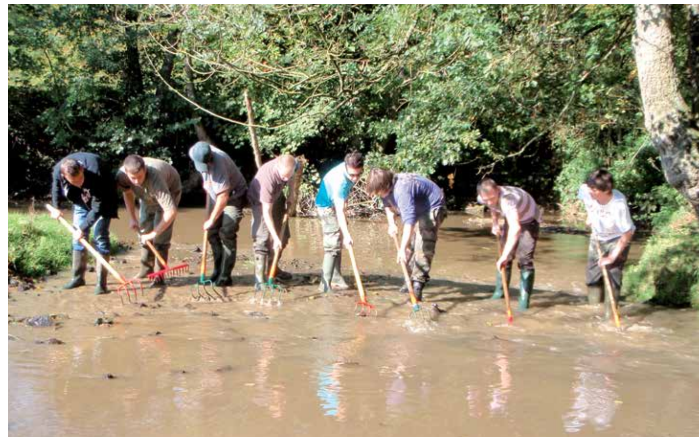
Aménagement d'une frayère, fédération départementale du Nord
