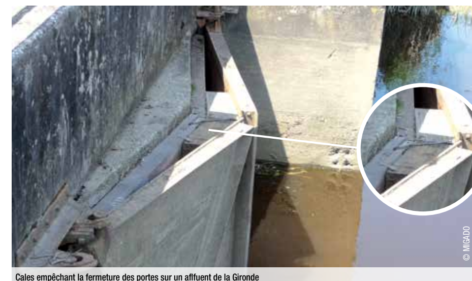
Cales empêchant la fermeture des portes sur un affluent de la Gironde
