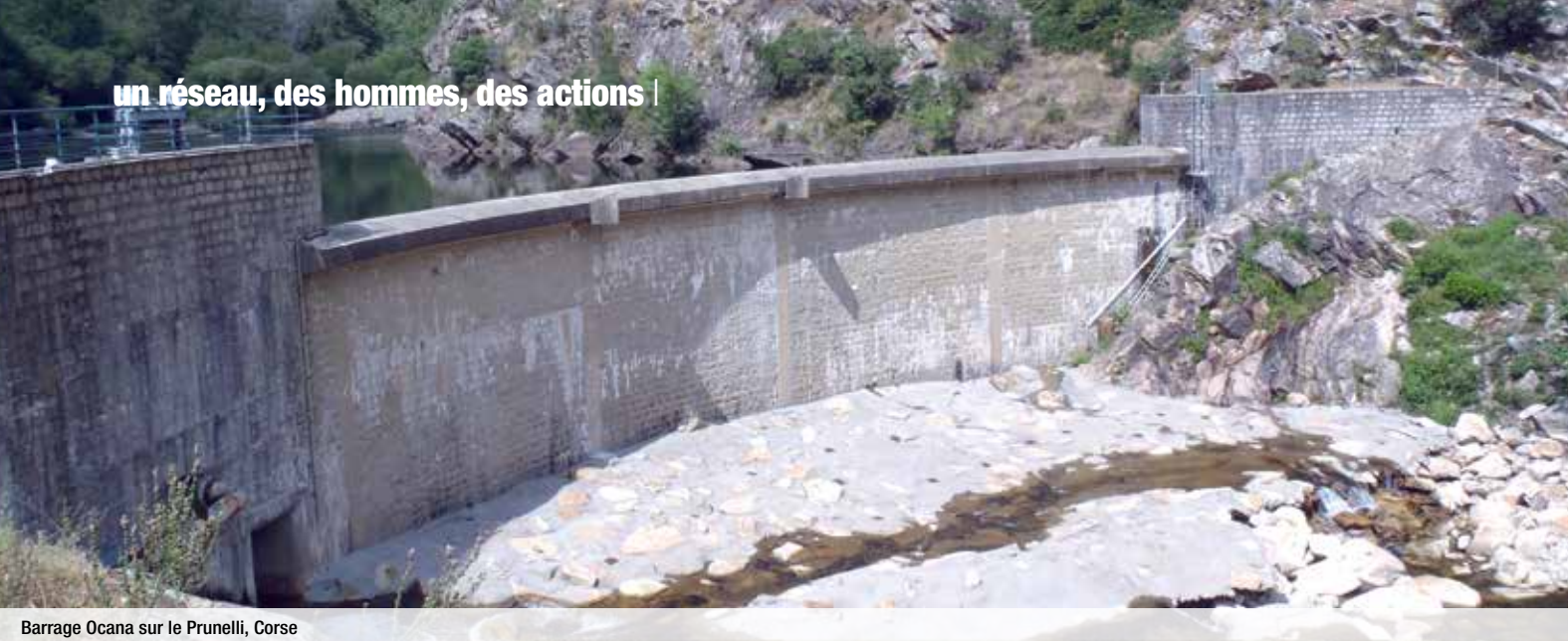
Barrage Ocana sur le Prunelli, Corse
