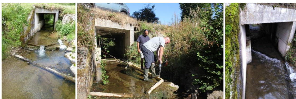
[Photos : Pont du Greissentous en juin 2016, travaux en août 2016 et novembre 2019]
