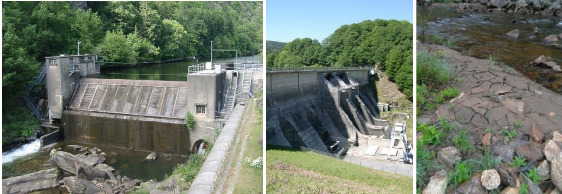
[Photos : Barrage du Baous sur l'Arn aval, barrage de La Ravière, limite amont du contexte Agout amont – Couche de vase après la vidange de Pontviel en 2019, contexte Agout amont]
