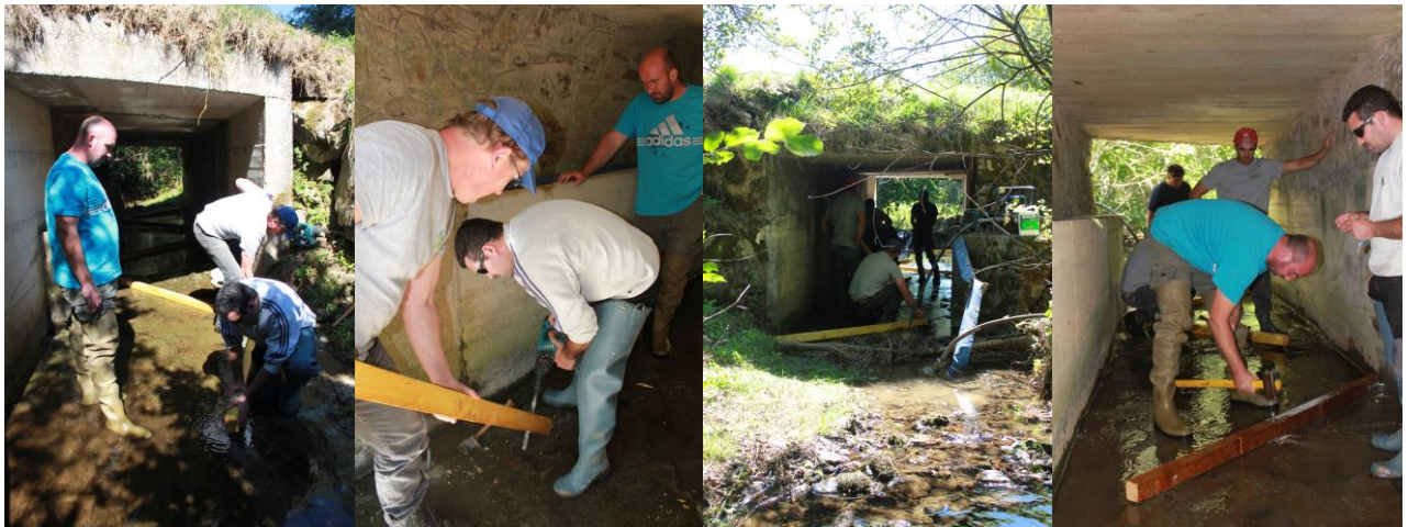
Mise en place épis – août 2015
