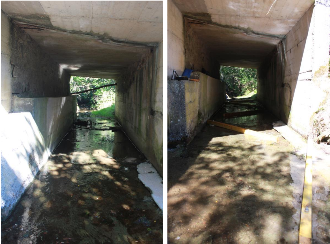
Vue de l'intérieur du pont avant et après les travaux – août 2015
