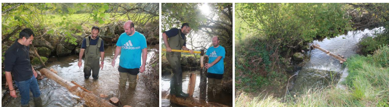
Mise en place du pré-seuil – octobre 2014
