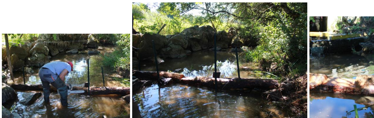
Mise en place pré-seuil – août 2015
