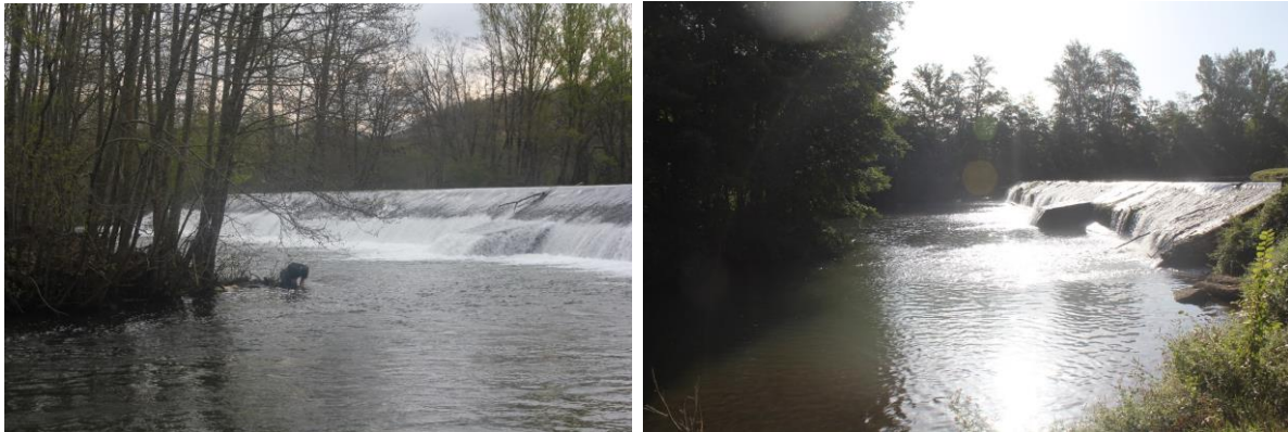
Vue vers l'amont (04/04/2017 et 29/08/2017)
