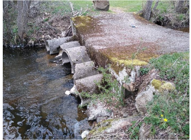
Vue de l'ouvrage depuis la rive gauche
