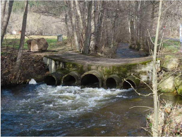
Vue de l'ouvrage depuis l'aval (source : OFB SD43)
