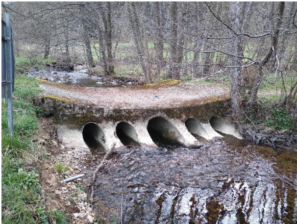
Vue de l'ouvrage depuis l'amont
