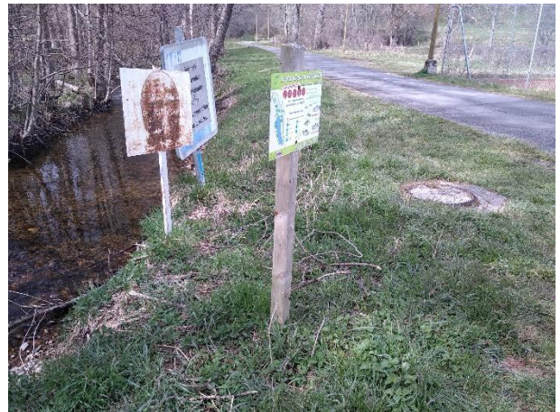
Vue de la berge amont RG et du regard AEP
