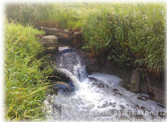
Figure 26 : Seuil du gabion à basse mer
