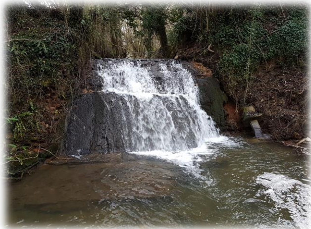
Figure 12 : Seuil de la ferme du Manoir
