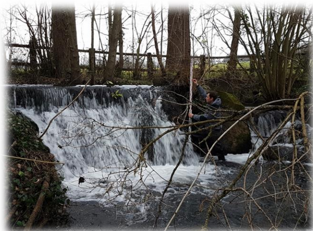
Figure 17 : Seuil de la ferme du Liquaire
