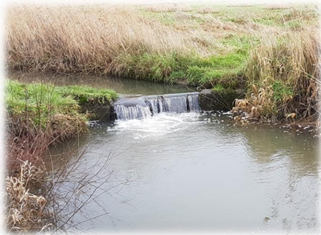
Figure 25 : Seuil du gabion à pleine mer de coefficient 84
