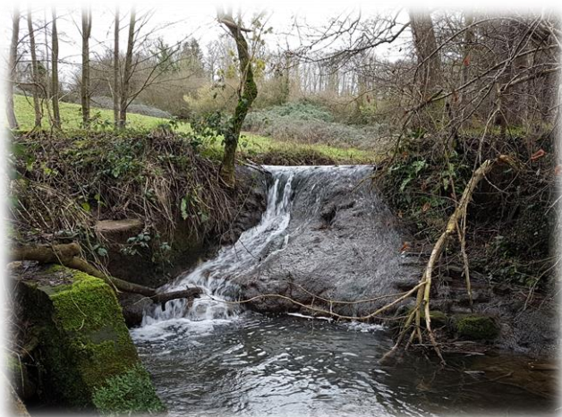
Figure 14 : Seuil du château de Manerbe sur le ruisseau de la Planche des Douets
