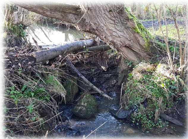
Figure 19 : Seuil du plan d'eau du Lieu Cordier sur le Douet du Houlbec
