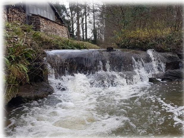
Figure 24 : Seuil du Lieu au Bon
