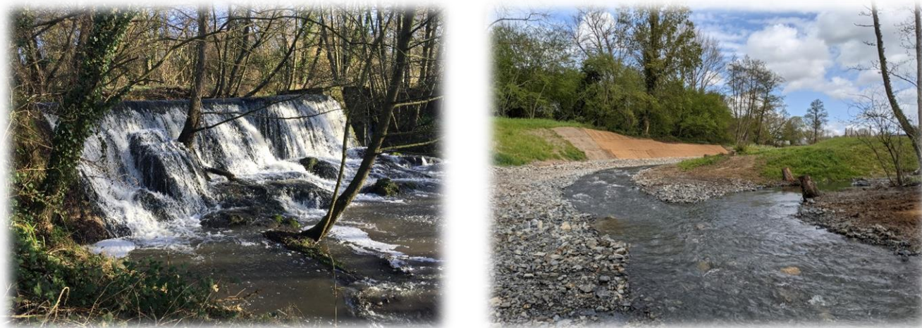
Figure 6 : Situation avant et après travaux d'effacement
