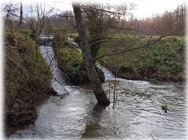
Figure 29 : Digue du plan d'eau aval de Montaval
