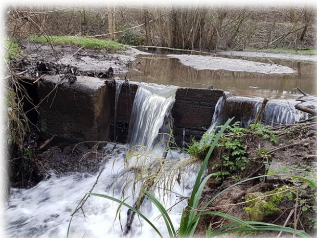
Figure 30 : Seuil du plan d'eau amont de Montaval
