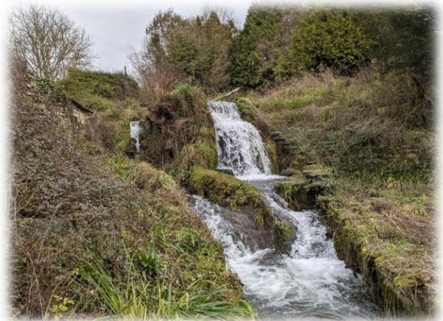
Figure 18 : Seuil ancien moulin à blé (ROE14093)
