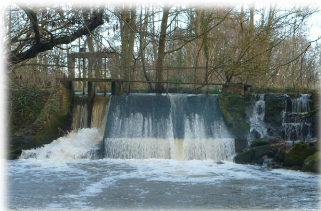
Figure 11 : Barrage infranchissable du Moulin de la Porte sur l'Ancre
