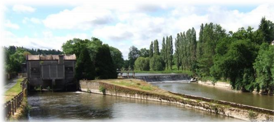
Figure 11 : Usine hydroélectrique de Brieux
