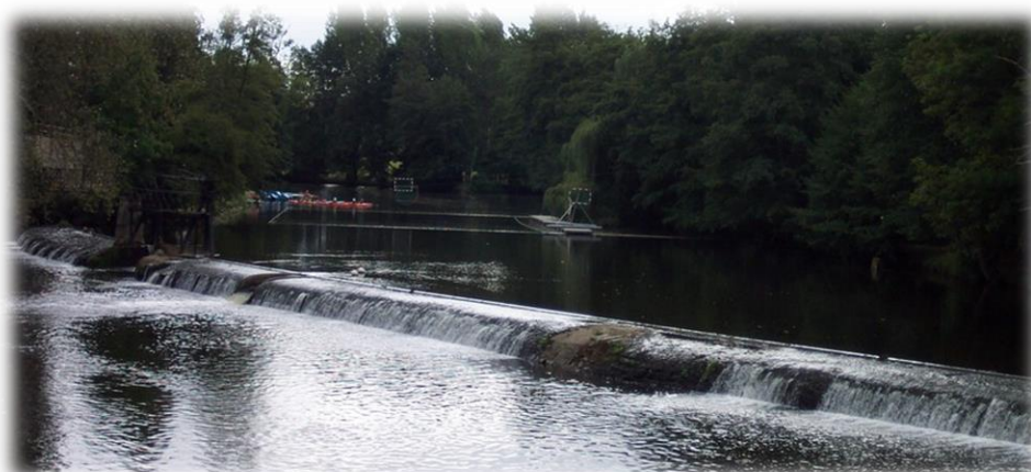
Figure 17 : Seuil de Pont-d'Ouilly
