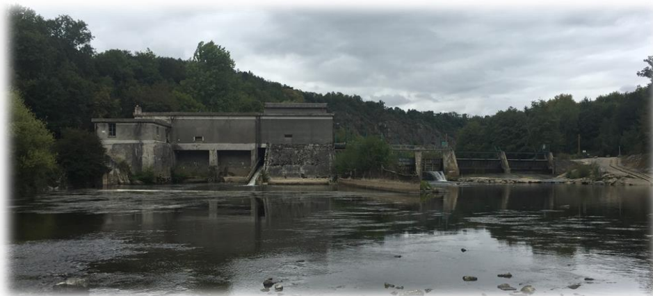
Figure 15 : Usine hydroélectrique de la Courbe
