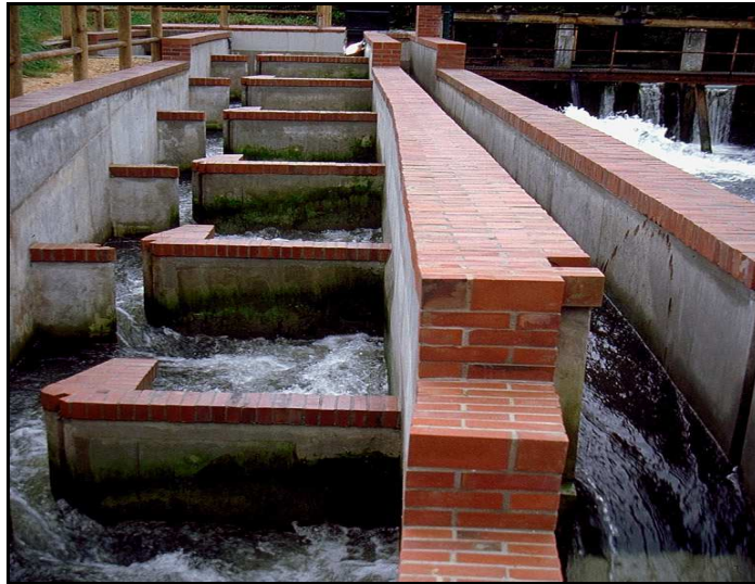
Figure 3 : Passe à bassins successifs du barrage du Breuil-en-Auge
