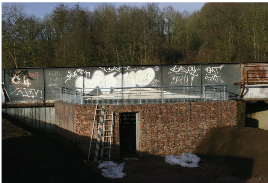
Vue de la station côté entrée
