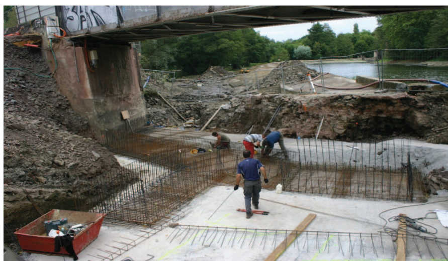
Pose des aciers avant élévation début septembre
