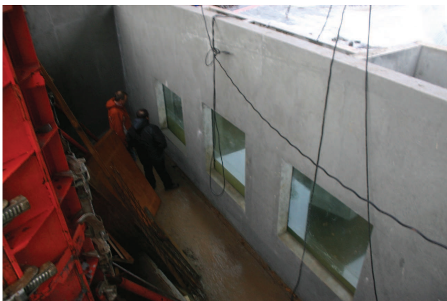
La pose des vitres dans les bassins mi-novembre
