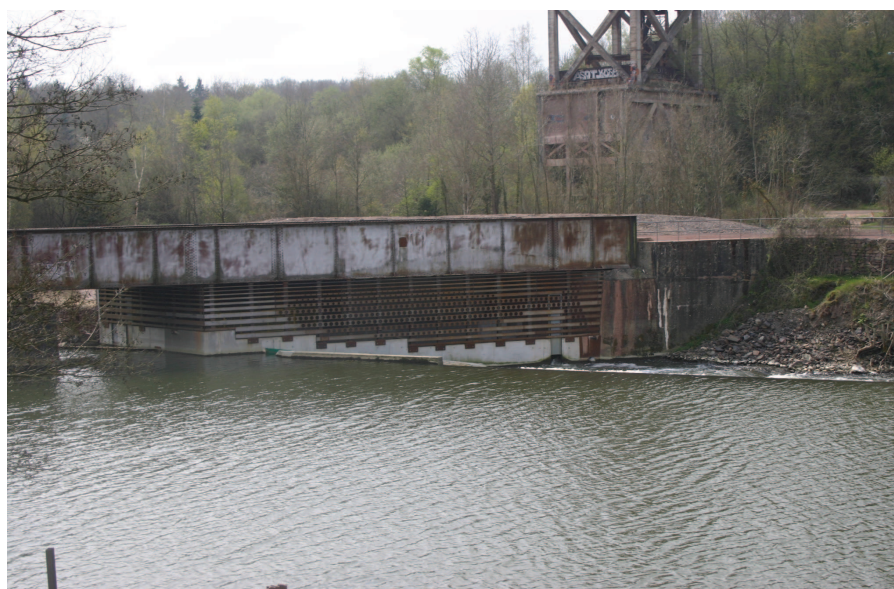
Vue de la station côté claustra
