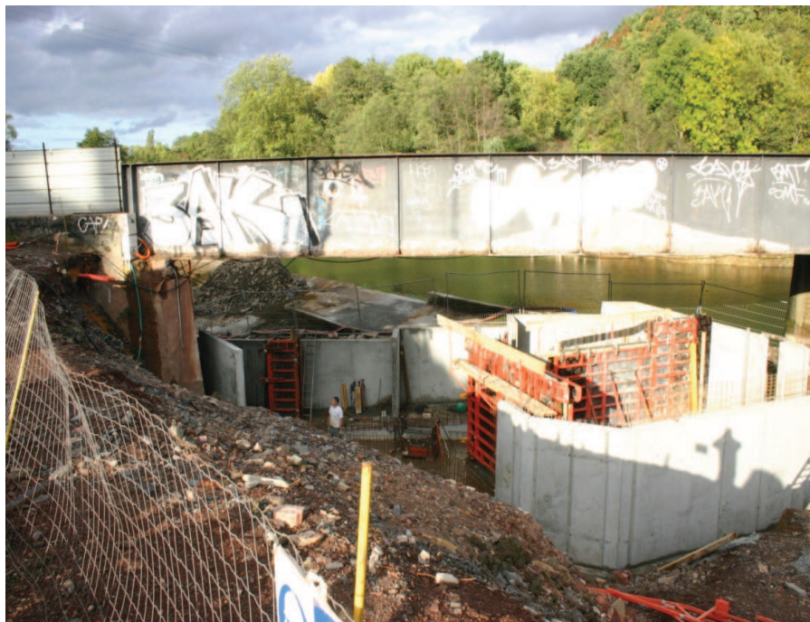
Coulage des voiles bétons fin septembre
