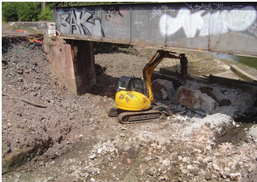
Début des travaux de démolition fin juillet
