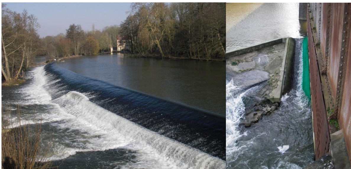
Figure 16 : Barrage du Grand Moulin à Feuguerolles/May-sur-Orne et sa passe à anguilles. (© Geoffroy GAROT – SEINORMIGR).
