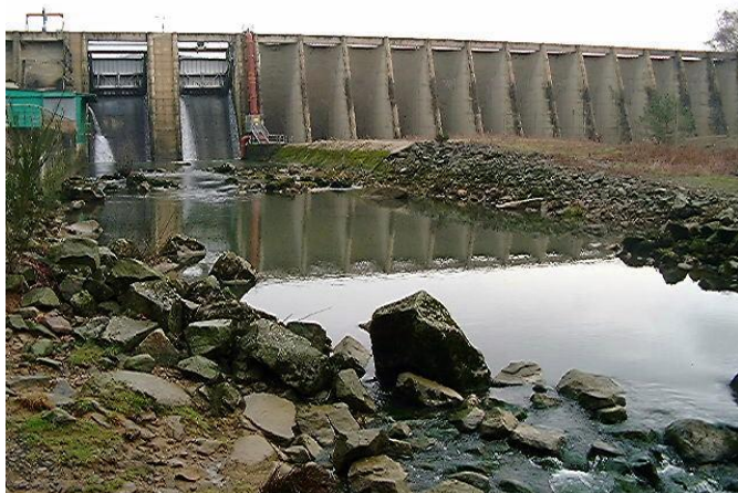
Figure 7 : Barrage à voûtes multiples et contreforts de la centrale hydroélectrique EDF de Rabodanges (département de l'Orne). Achevé en 1959, haut de 20 mètres et long de 160 mètres, l'ouvrage, toujours pas équipé à
