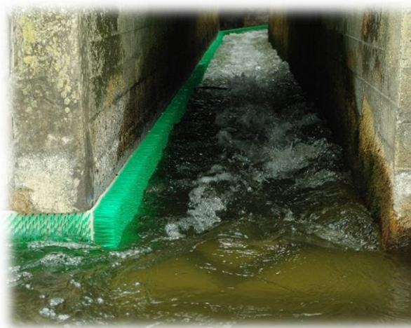
Figure 11 : Passe à poissons en rive gauche (Source : Geobs)
