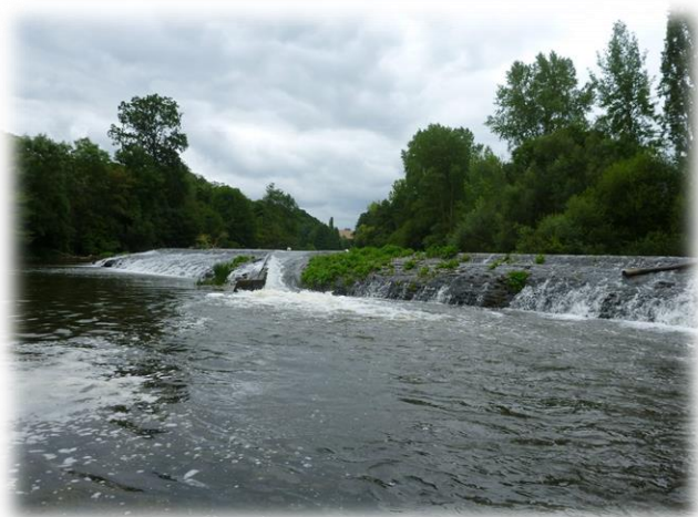
Figure 41 : Déversoir de la Mousse
