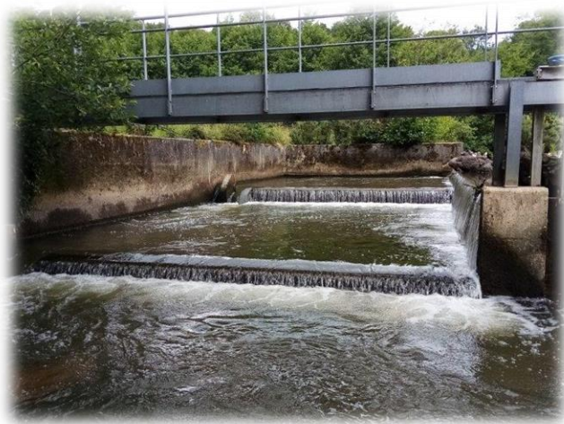
Figure 20 : Seuil pompage usine AEP
