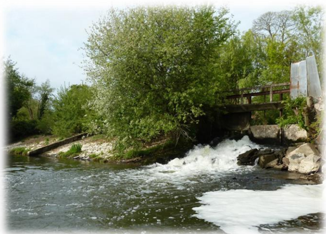
Figure 28 : Seuil de dérivation du moulin de Guelle
