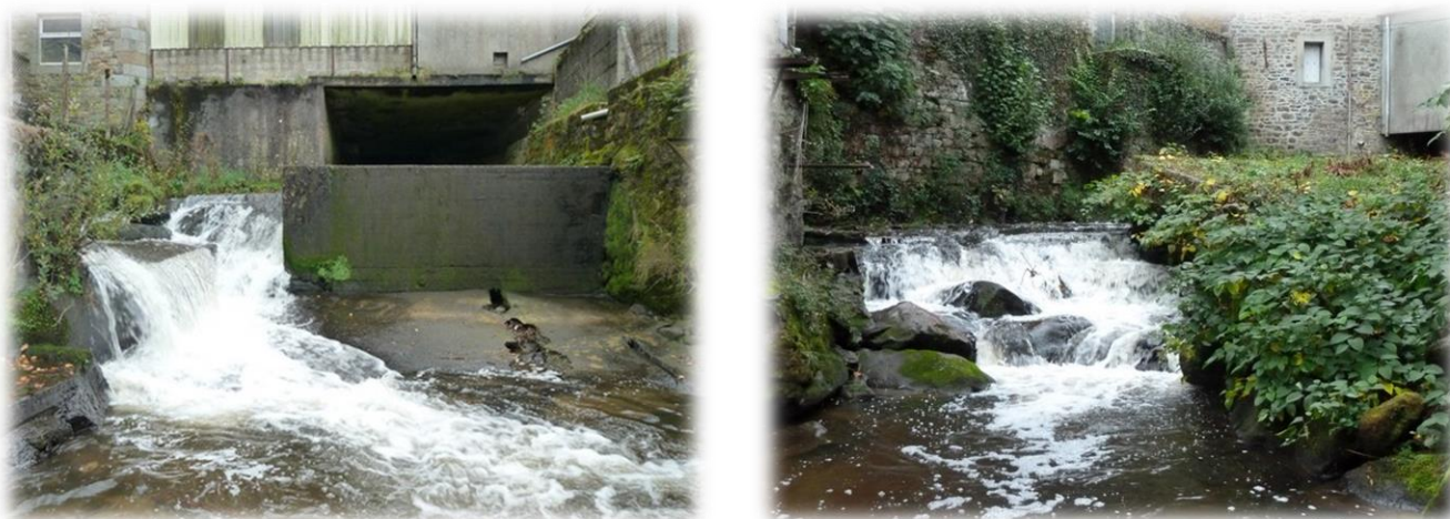
Figure 18 : Ouvrages dans le secteur des Vaux-de-Vire
