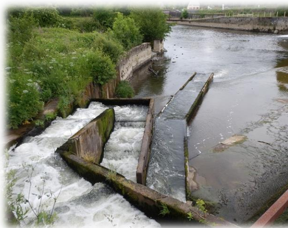
Figure 10 : Passe à poissons en rive gauche (Source : Geobs)
