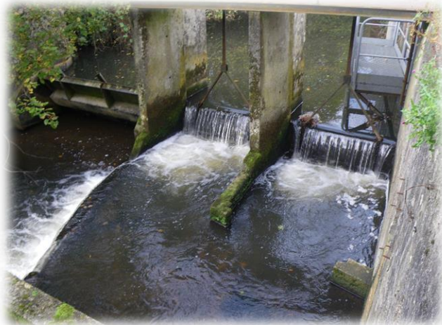
Figure 24 : Prise d'eau des Maitres Laitiers
