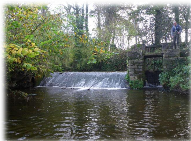
Figure 23 : Seuil de dérivation moulin des Forges
