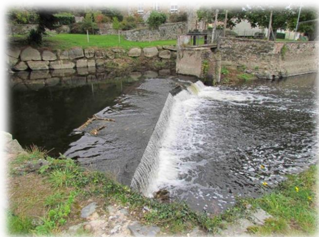
Figure 13 : Seuil de l'ancienne usine de la Potiche (Source : Geobs)
