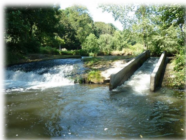
Figure 26: Seuil de dérivation du moulin des Pêcheries
