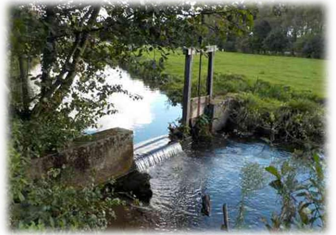
Figure 24 : Seuil de dérivation du Château du Vast
