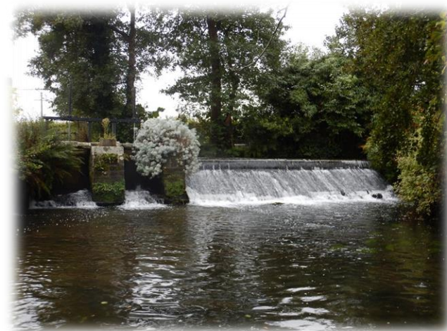
Figure 22 : Seuil de dérivation du moulin d'Esseules
