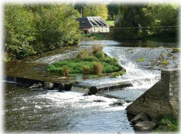
Figure 16 : Seuil de la base de de canoë-kayak de Condé-sur-Vire
