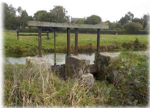
Figure 21 : Seuil de dérivation du moulin de Parquet
