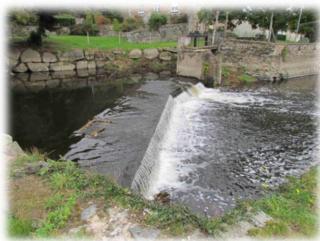
Figure 14 : Seuil de l'ancienne usine de la Potiche (Source : Geobs)
