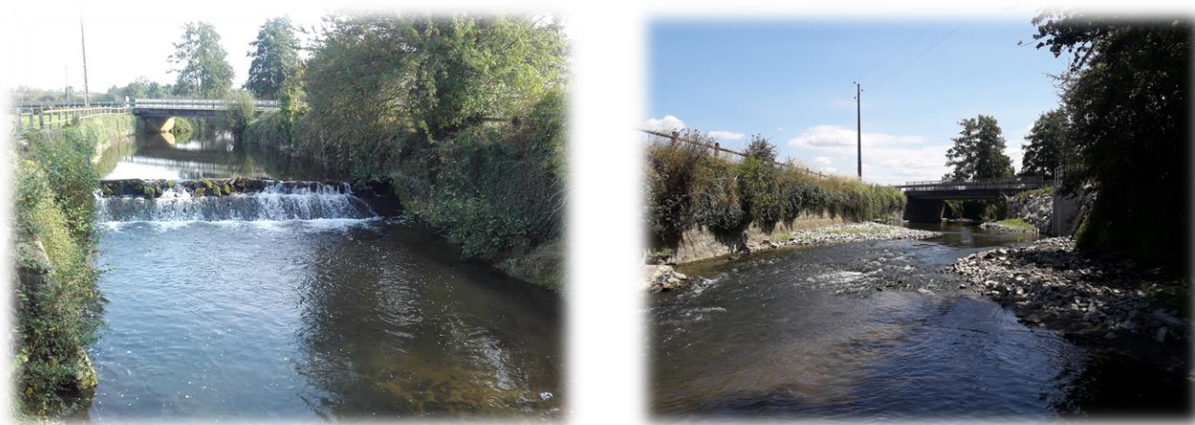
Figure 31 : Seuil de l'ASA de la Vie avant et après travaux
