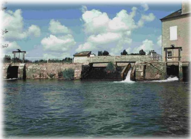
Figure 21 : Seuil de dérivation du moulin de la Chasse
