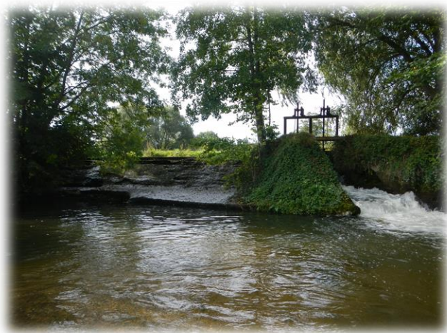
Figure 15 : Seuil de dérivation moulin Magny-le-Freule
