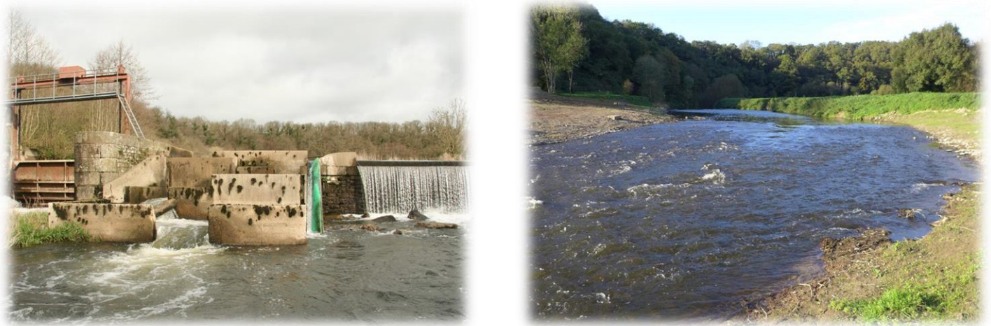
Figure 12 : Seuil de Fourneaux avant et après travaux
