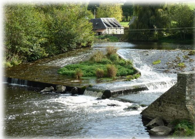
Figure 13 : Seuil de la base de de canoë-kayak de Condé-sur-Vire
