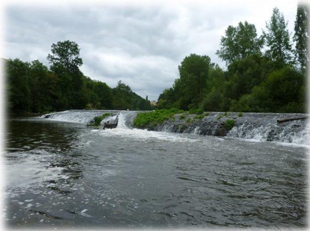
Figure 27 : Déversoir de la Mousse
