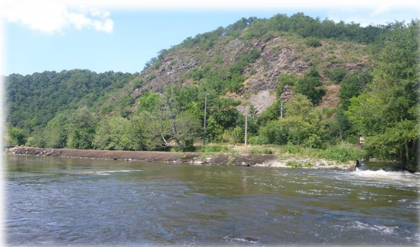
Figure 9 : Seuil du Hom
