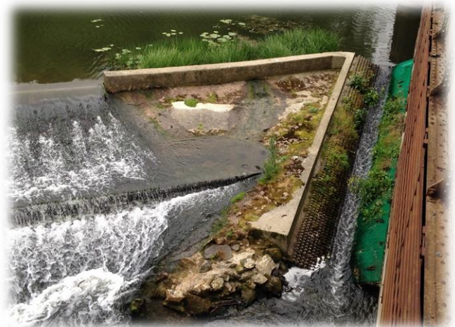
Figure 28 : Rampe anguille au niveau du barrage du Grand Moulin
