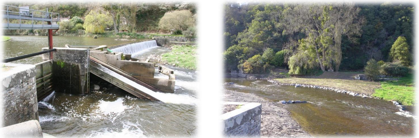
Figure 11 : Seuil de la Roque avant et après travaux
