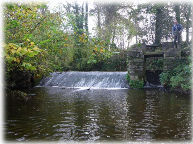
Figure 15 : Seuil de dérivation moulin des Forges
