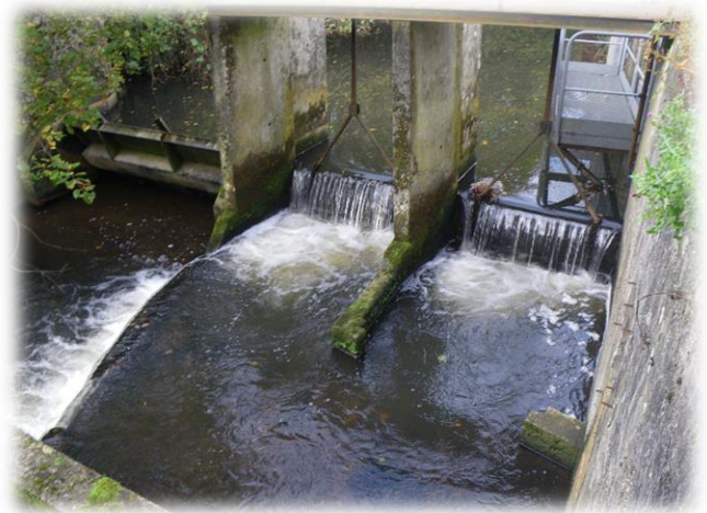
Figure 16 : Prise d'eau des Maitres Laitiers
