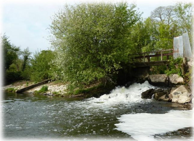
Figure 18 : Seuil de dérivation du moulin de Guelle
