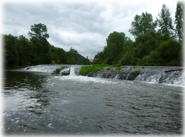
Figure 28 : Déversoir de la Mousse
