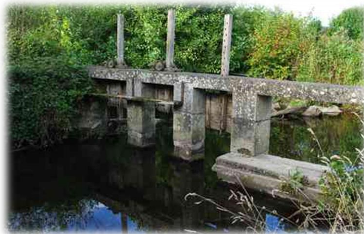
Figure 36 : Seuil du moulin de Cuves
