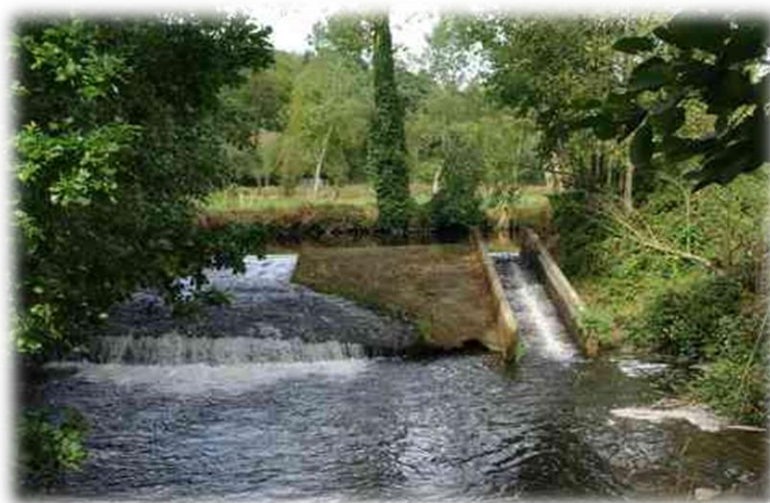
Figure 20 : Seuil du moulin des Pêcheries
