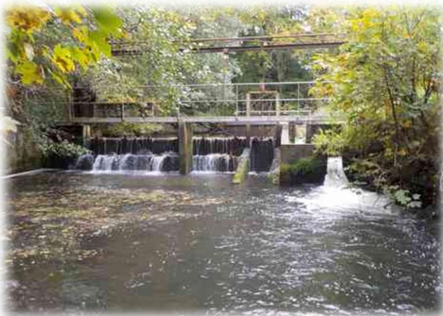
Figure 16 : Seuil de dérivation de la pisciculture du Houx
