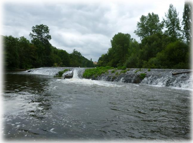
Figure 30 : Déversoir de la Mousse
