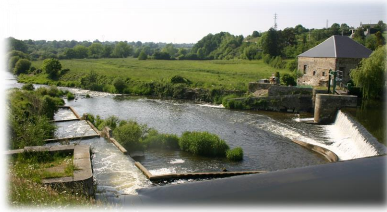
Figure 33 : Barrage de Candol
