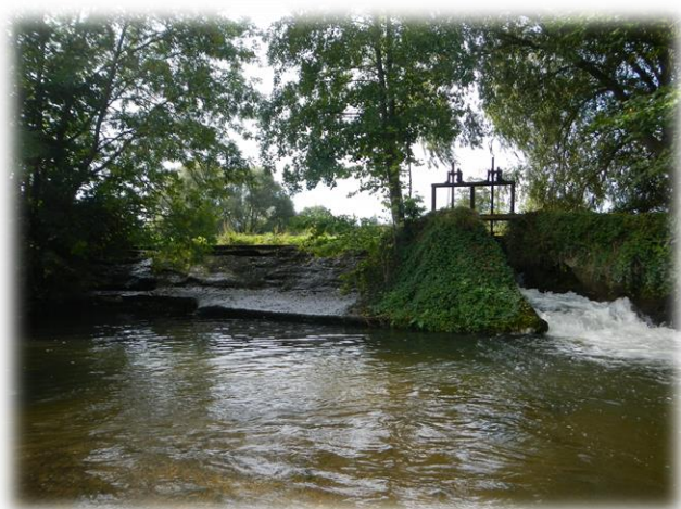
Figure 23 : Seuil de dérivation moulin Magny-le-Freule
