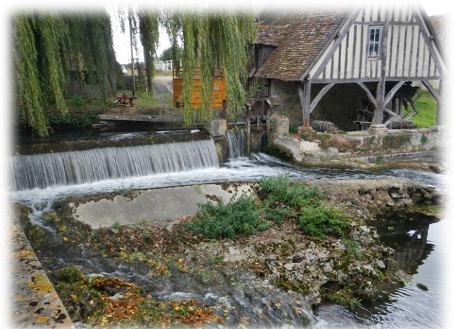
Figure 24 : Seuil bief moulin Magny-le-Freule
