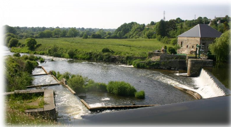
Figure 37 : Barrage de Candol
