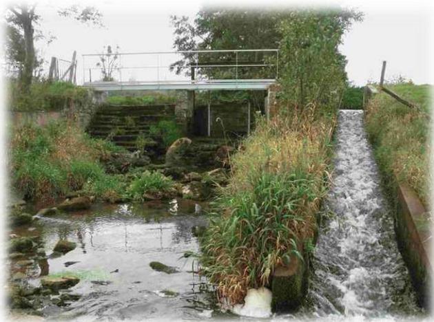
Figure 28 : Seuil de dérivation du moulin de Creully
