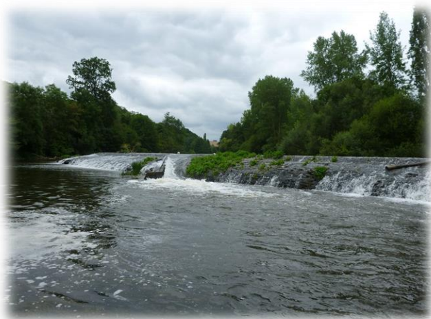
Figure 34 : Déversoir de la Mousse
