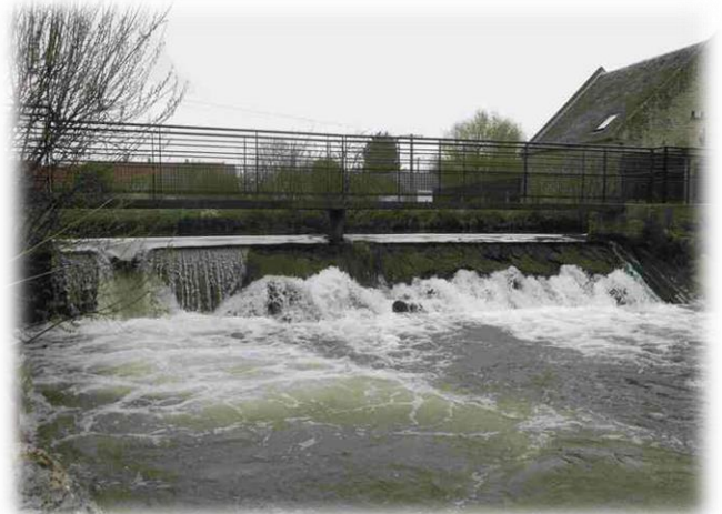
Figure 31 : Seuil de dérivation du moulin de Langonney
