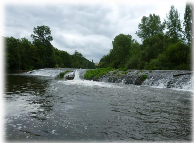
Figure 31 : Déversoir de la Mousse
