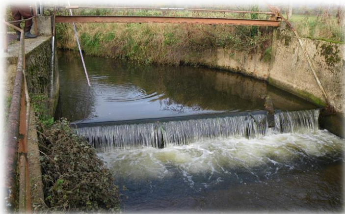
Figure 23 : Seuil de la prise d'eau de Pont Rault
