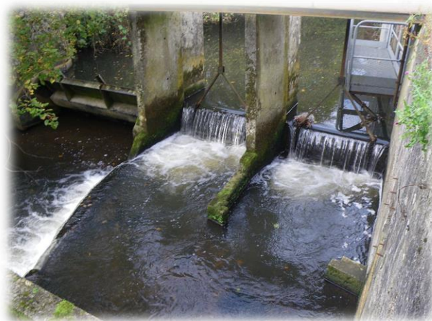
Figure 25 : Prise d'eau des Maitres Laitiers
