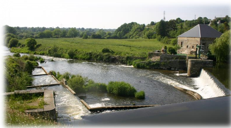
Figure 34 : Barrage de Candol
