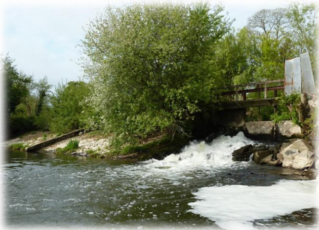
Figure 28 : Seuil de dérivation du moulin de Guelle
