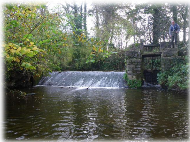
Figure 24 : Seuil de dérivation moulin des Forges
