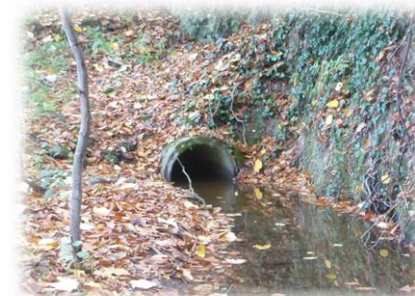
Buse n°2 : vue amont avec entrée obstruée (à gauche), vue aval (à droite)
