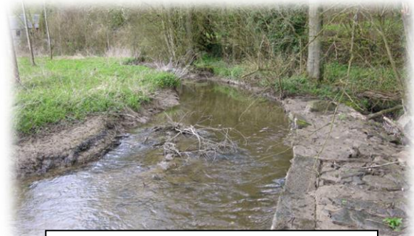
Arrivée du Cresme en amont de l'ouvrage
