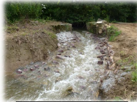
Exemple de passe rustique aménagée sur la Laize
