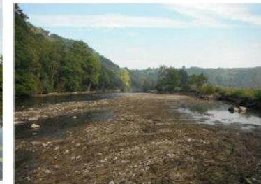
Radier au même endroit en situation de vannes ouvertes
