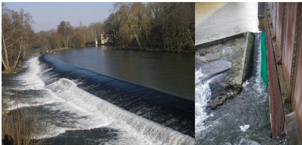
Figure 13 : Barrage du Grand Moulin à Feuguerolles/May-sur-Orne et sa passe à anguilles. (© Geoffroy GAROT – SEINORMIGR).
