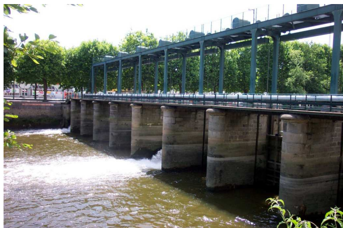
Figure 8 : Barrage de Caen situé sur le Cours Montalivet servant à alimenter et réguler le niveau d'eau du canal de Caen à la mer. Premier obstacle du plus grand fleuve bas-normand, situé à près de 18 kilomètres de la limite transversale de la mer, l'ouvrage marque ainsi le fond de l'estuaire de l'Orne. (© Arnaud RICHARD – ONEMA).
