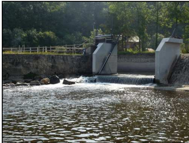
Figure 16 : Barrage de Brioux
