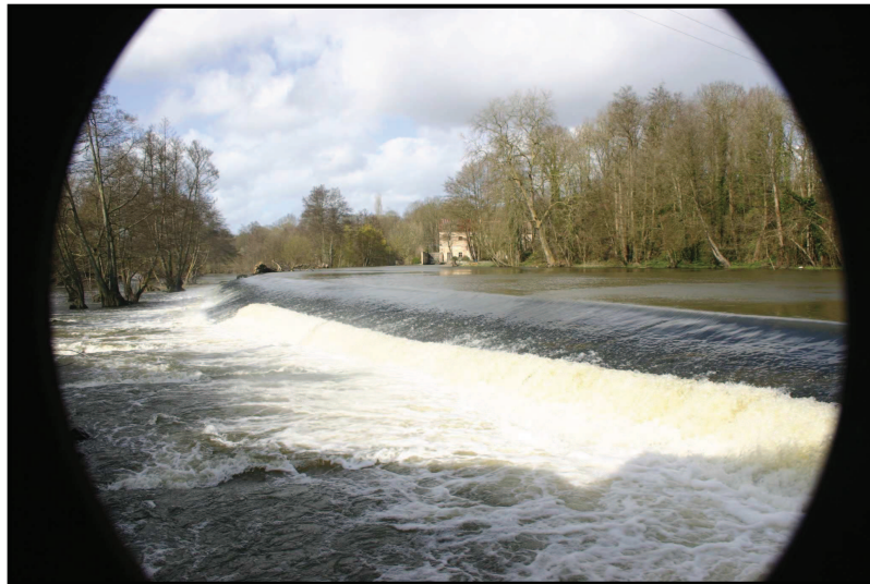
Photo 2 : Barrage du Grand Moulin vu de la passe.
